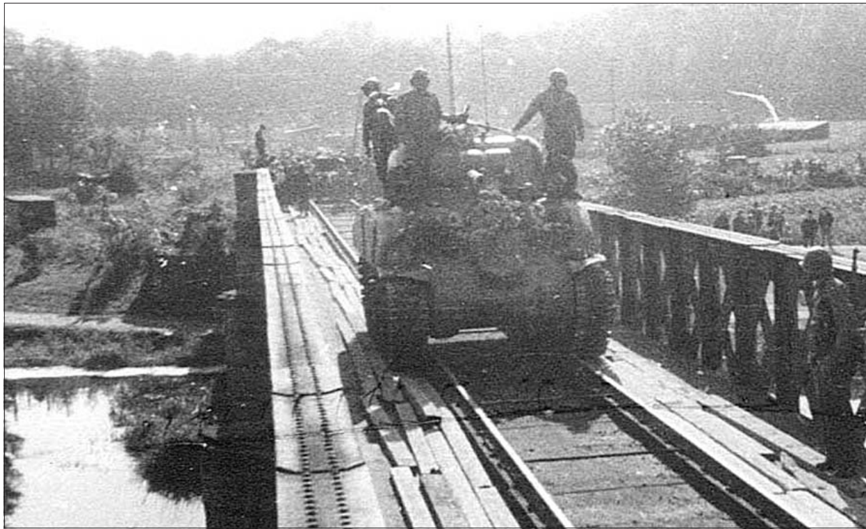
Ein weiterer Panzer rasselt heran. Klar erkennbar die Holzplancken aus dem Baudepot „Schou“.
