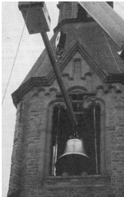
Die Glocken werden in den Turm gehoben
